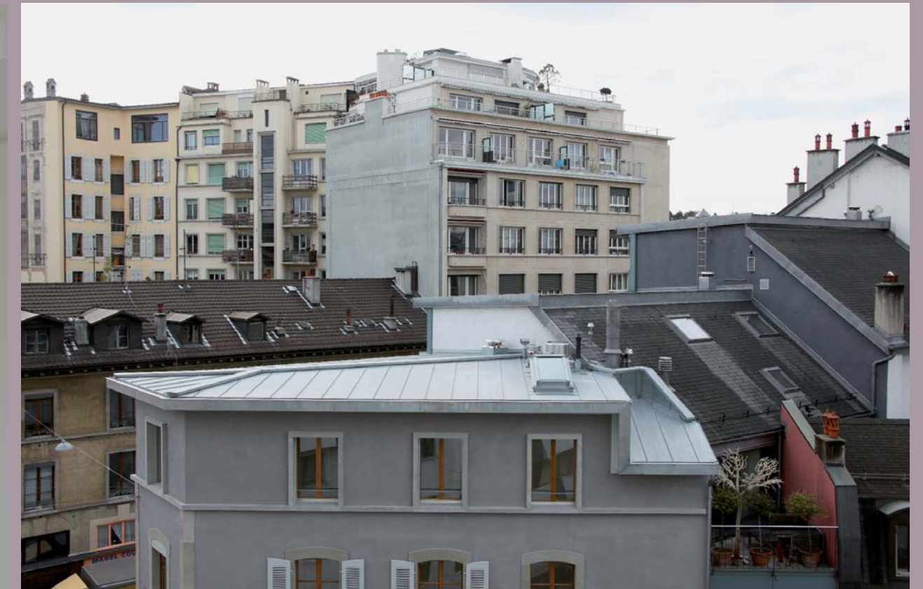
SURÉLÉVATION-TOITURE, CÔTÉ RUE DU PARC
